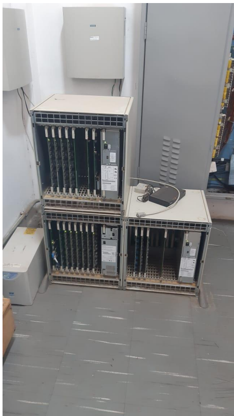
Figura 16 - Equipamento PABX Paço
