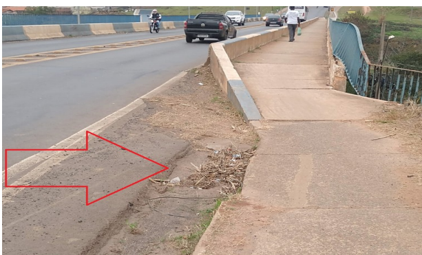
Boca de lobo eixo 1
