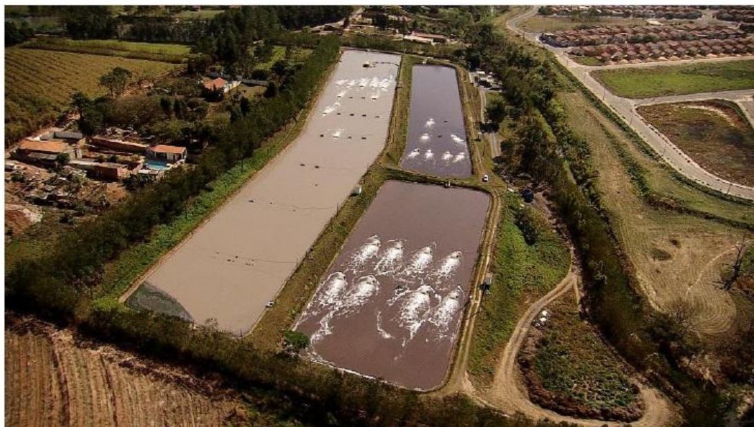
FIGURA 16: Vista de uma das Lagoas Aeradas da ETE Graminha
