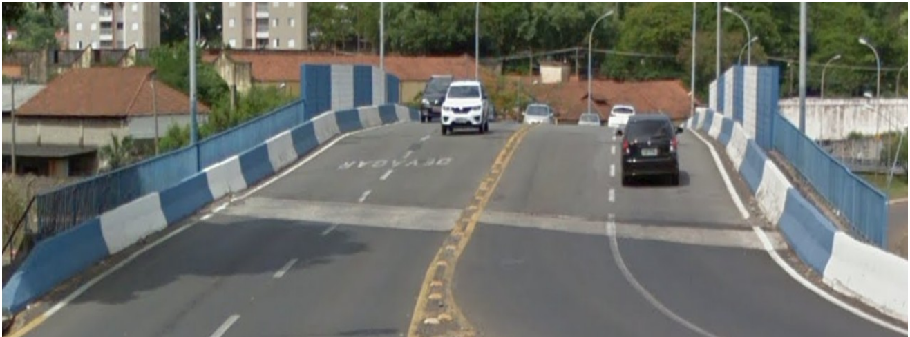
Vista centro ao bairro
