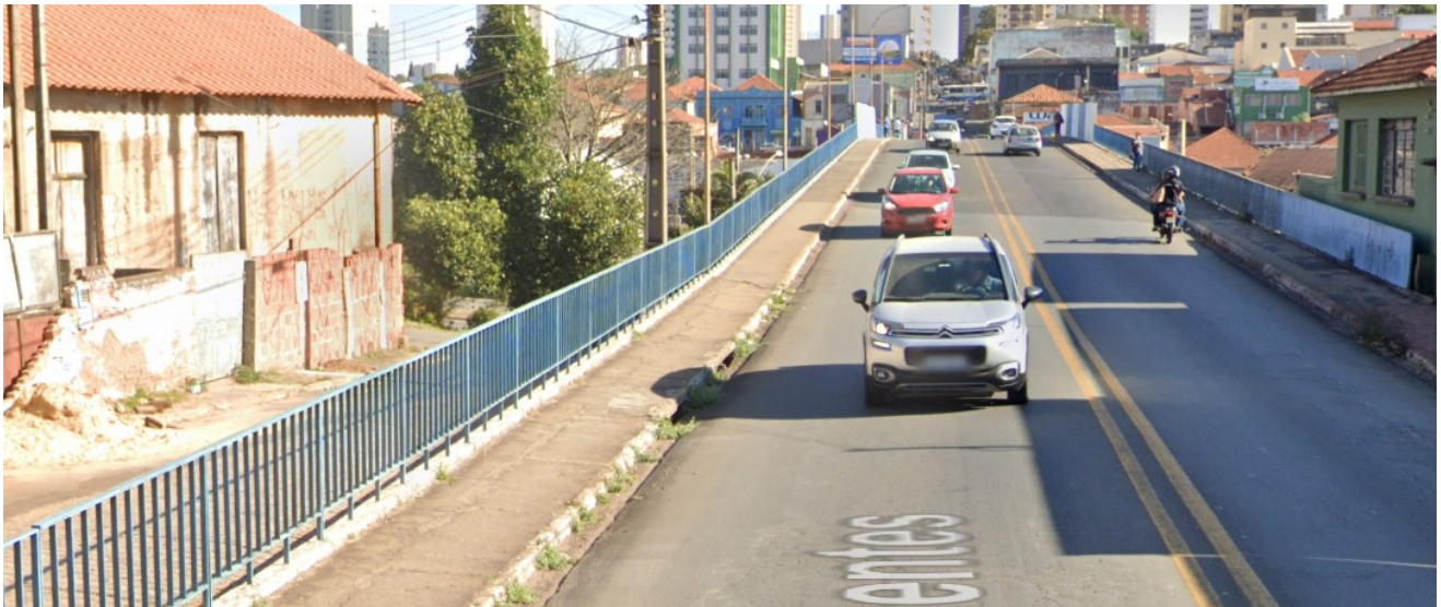
Vista do estrado do eixo 9 ao 1 ( bairro ao centro)
