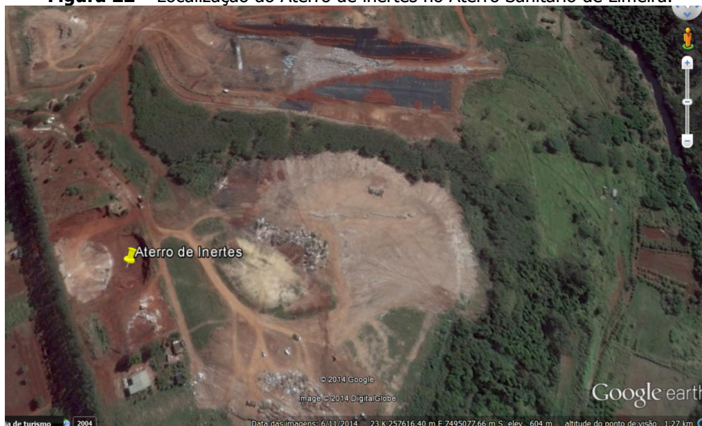
Figura 22 – Localização do Aterro de inertes no Aterro Sanitário de Limeira.
