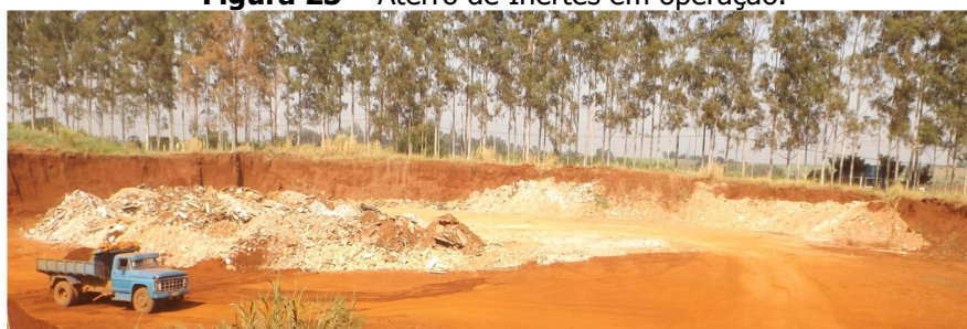
Figura 23 – Aterro de Inertes em operação.
